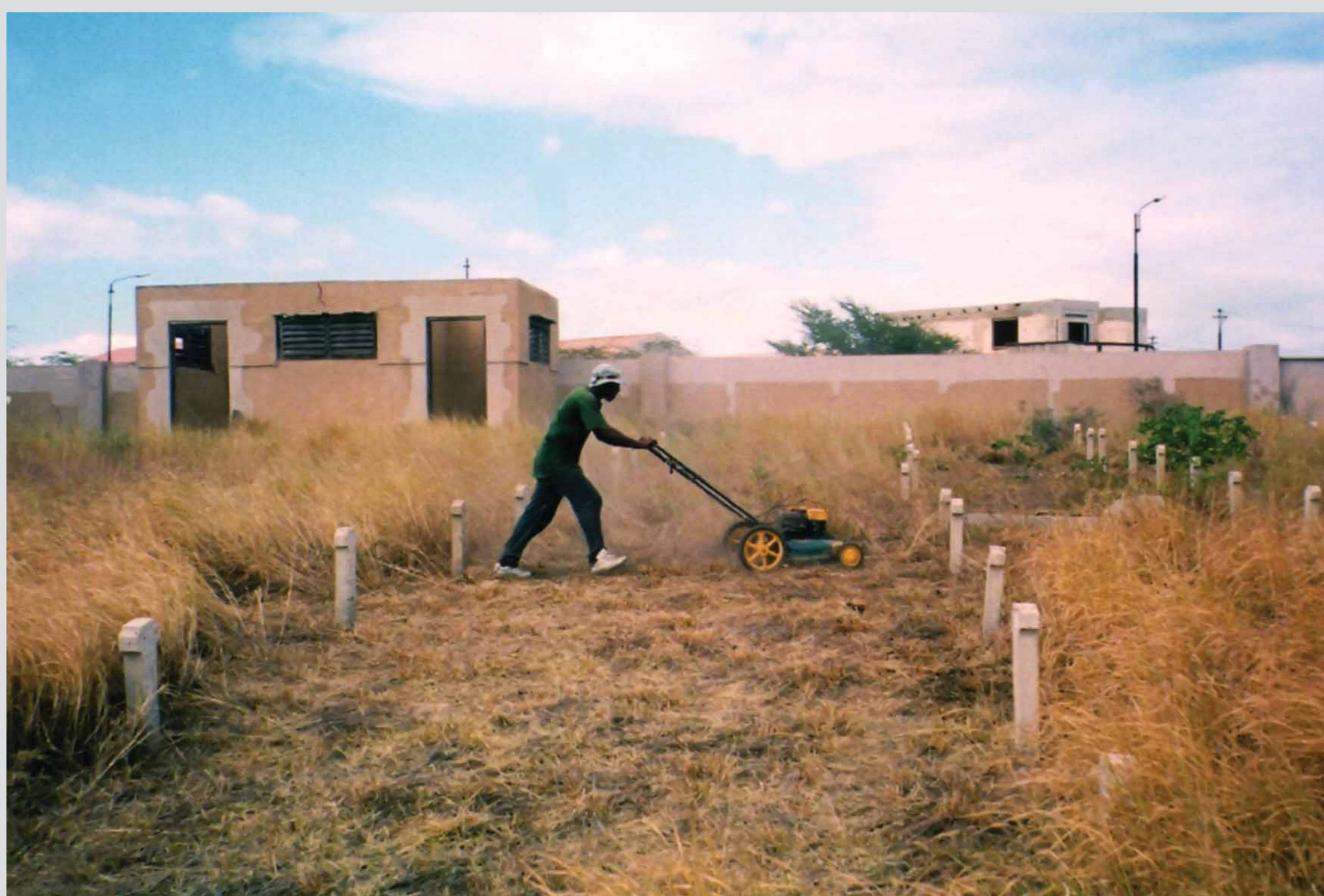
SEOC nam in 2003 het initiatief het verwaarloosde kerkhof voor heidenen, waar de Chinese stakers anoniem begraven liggen, grondig schoon te maken. Foto Nizaar Makdoembaks
